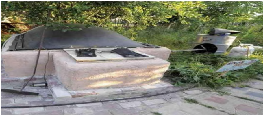
الشكل (I-4) : وحدة إنتاج غاز الميثان ( البيو غاز) [13].
