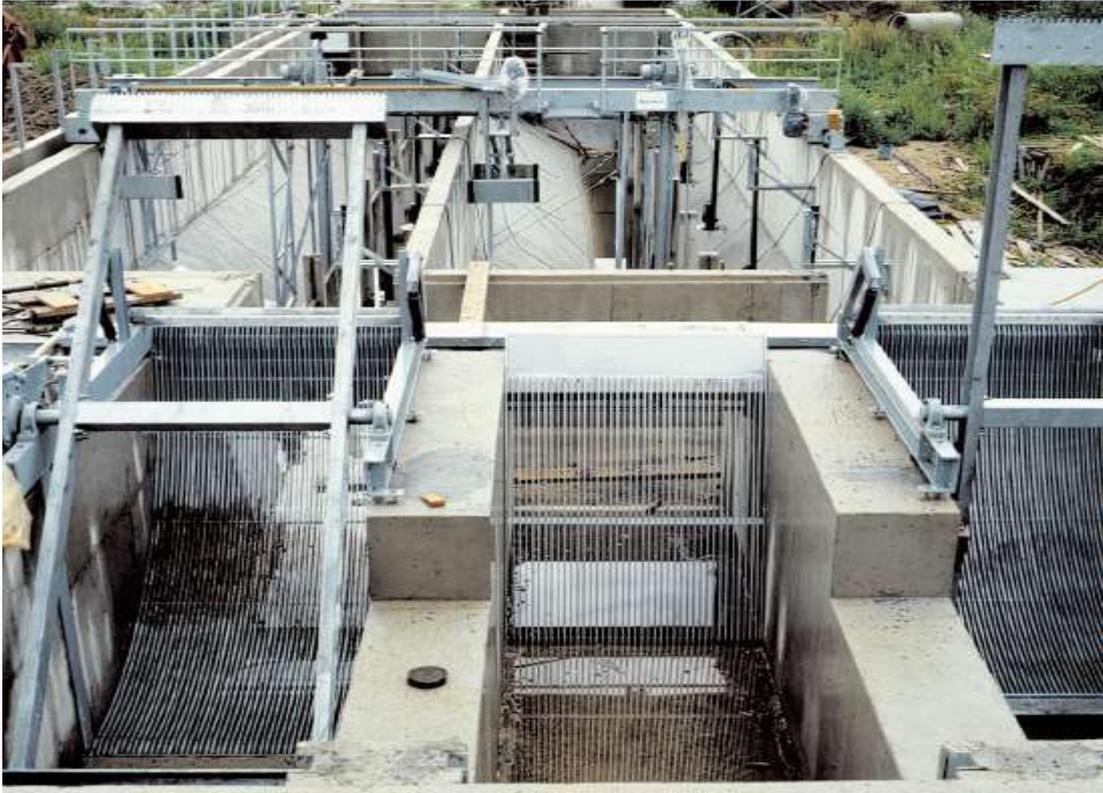
**Figure 2** Prétraitement- Dégrilleur
