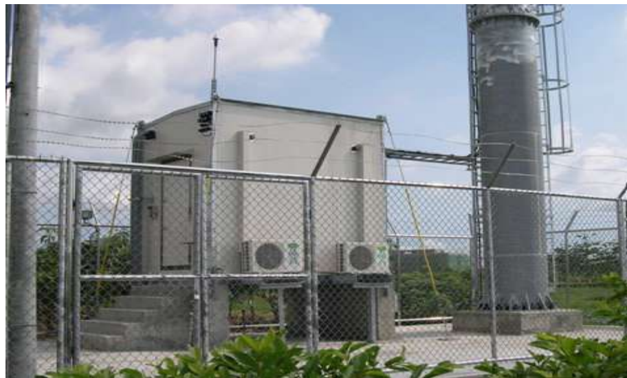
الشكل (6.1): التبريد بواسطة مكيف الهواء.
