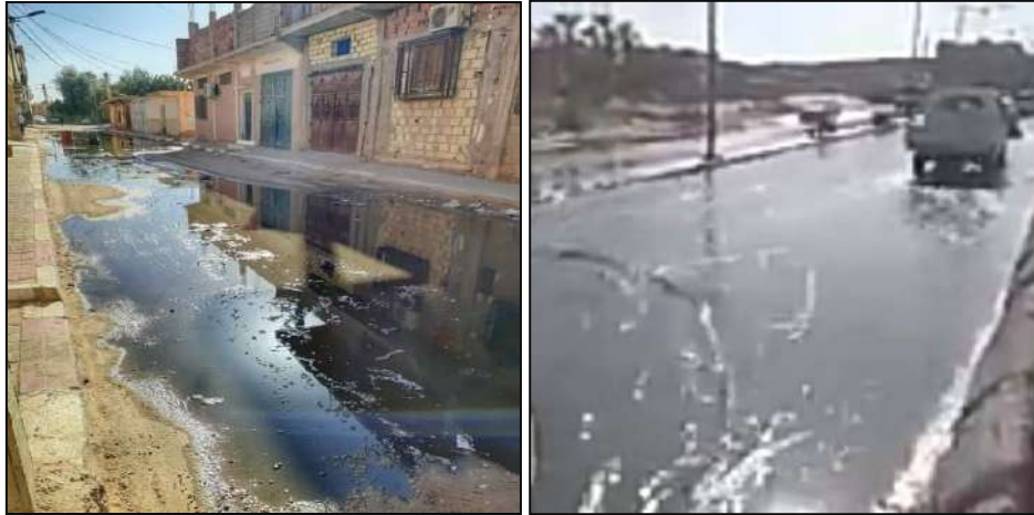
Photo 1. Affleurement des eaux usées dans la ville de Ouargla et Ain-Beida (Février 2020)
