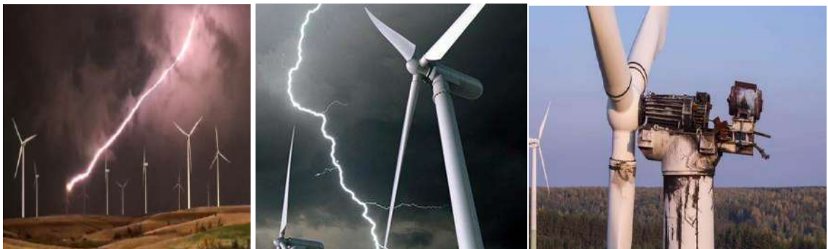
Fig. I.7 Turbines éoliennes exposés aux coups de foudre [7].
