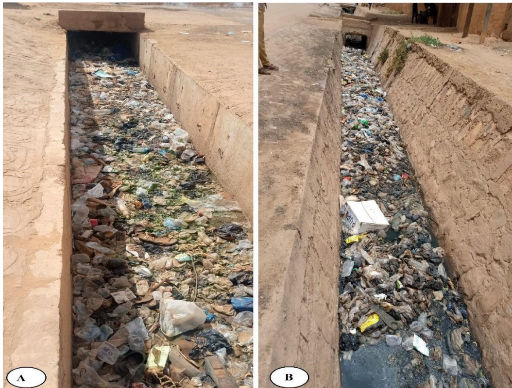
Figure 3 : A - Caniveau à parois cimentés drainant les eaux pluviales ; B : Caniveau à parois empierrés drainant les eaux usées et eaux pluviales
