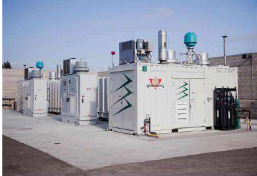
Figure 1.10: unité de pile à combustible [14].
