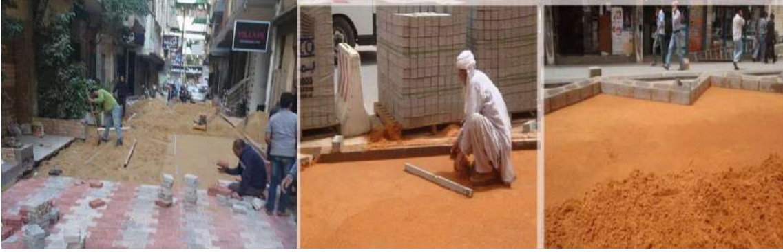
الصورة 9: عملية تبليط الرصيف ببلاط الإنترلوك
