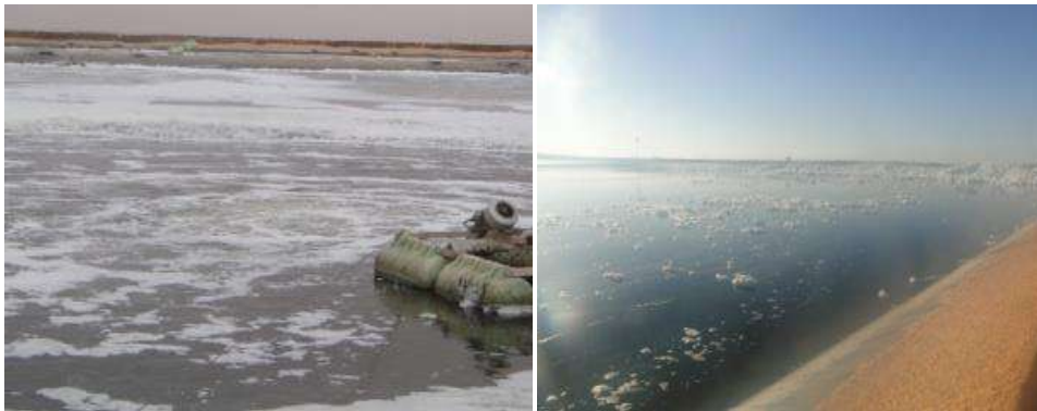
FIGURE (IV-7): Lagunes aérées de la station d'épuration Ouargla .
