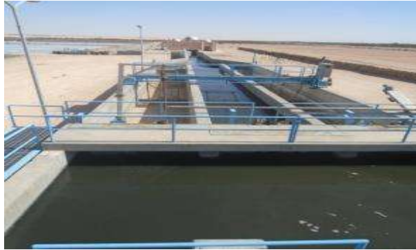
FIGURE (IV-5): enlèvement de la station d'épuration Ouargla.
