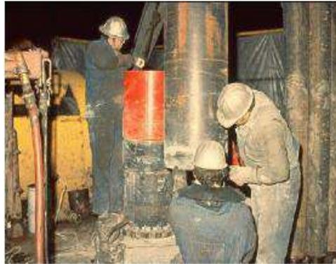
**Fig (15) : Opération de serrage et collage d'un anneau de retenue.**
