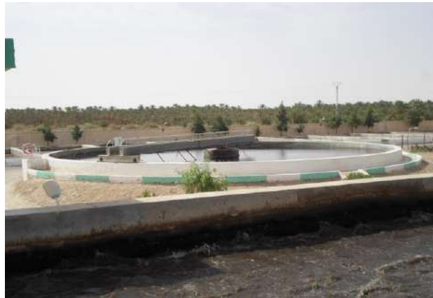
Figure III.10 décanteur secondaire
