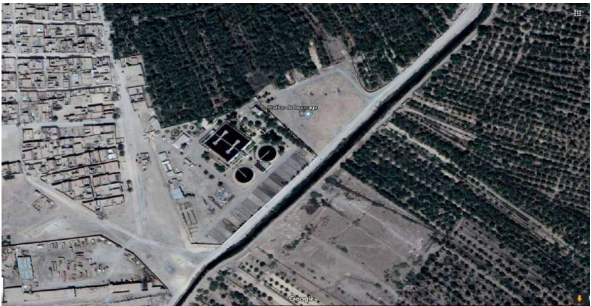
Figure III.1 : La station d'épuration des eaux usées de Touggourt.
