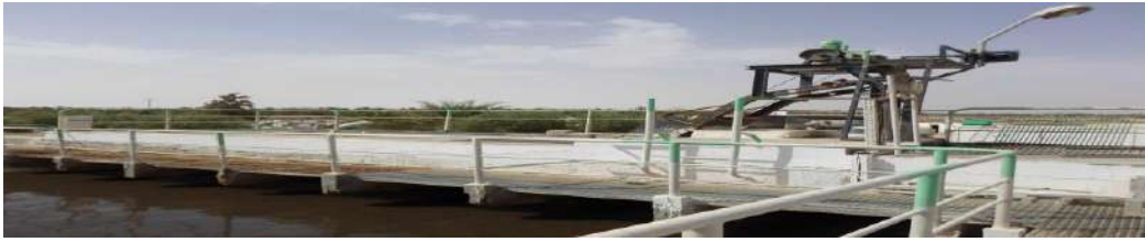
Figure III.7 Le Dégrillage
