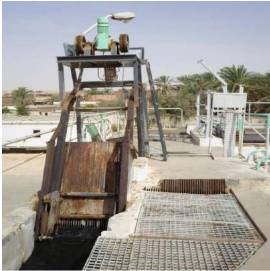
Figure III.16 Le Dégrillage
