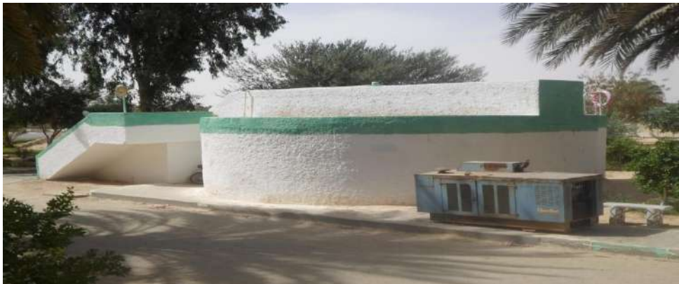
Figure III.13 L'épaississeur (boues en excès)
