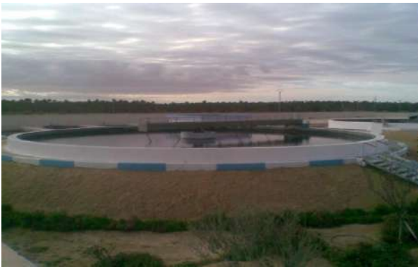
Figure III.19 décanteur secondaire
