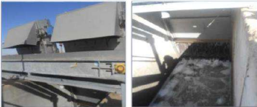
Figure III.24 Le dégrilleur
