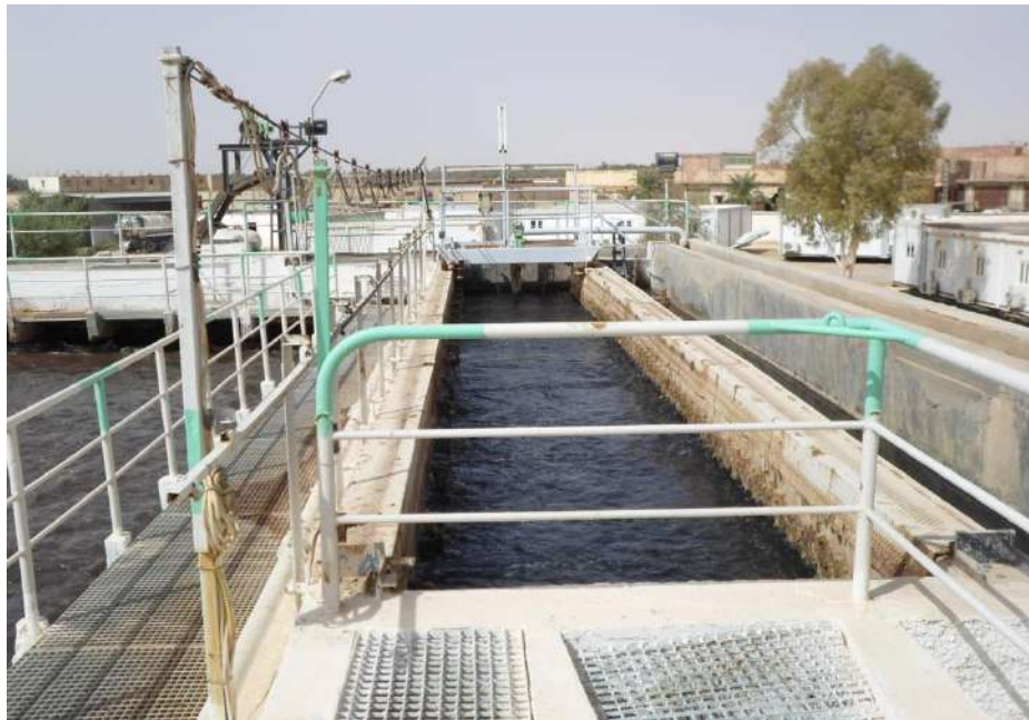
Figure III.8 Dessablage-déshuilage
