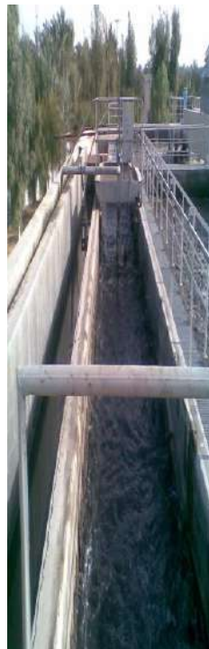
Figure III.17 Dessablage-déshuilage
