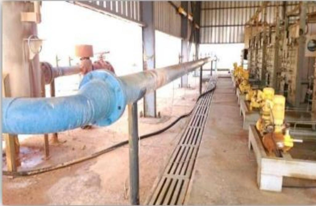
**Figure IV . 4 : Station de traitement d'eau par des produits chimiques [9]**
