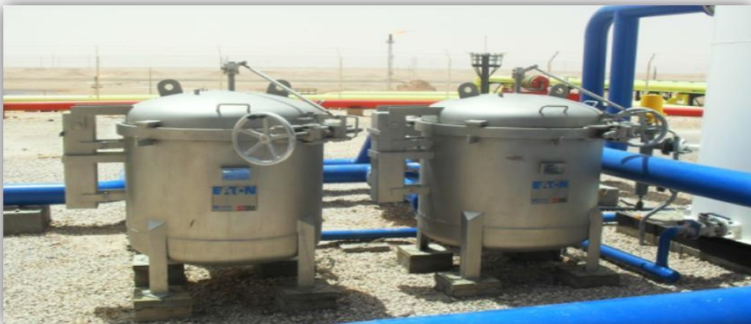
Figure II.18: Schéma simplifié de filtre à poche [16]
