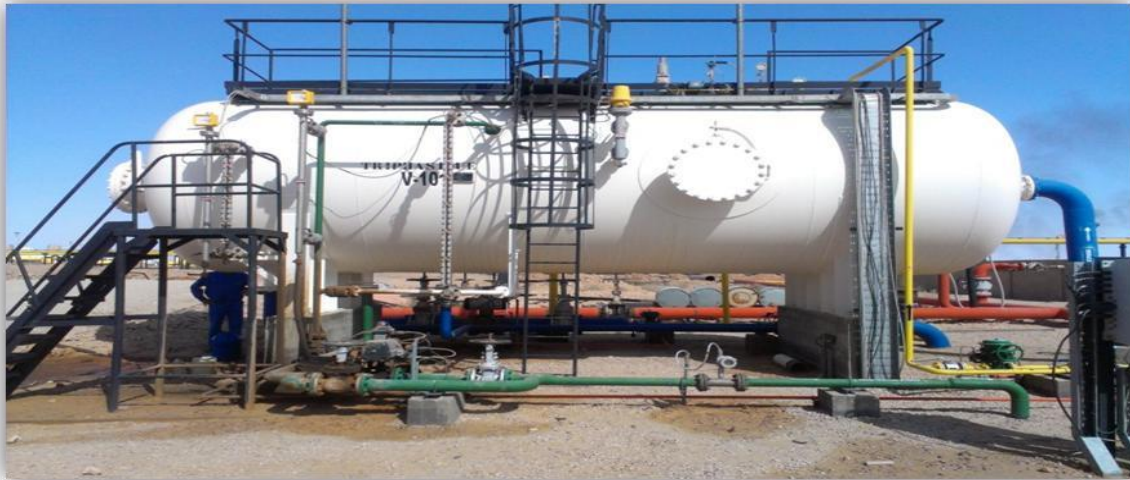
Figure II.9: Séparateur Tri-phasique [16]
