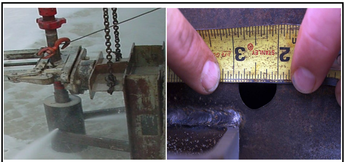
Figure II.8 : LES ESSAIS DE L'OPÉRATION À LA SURFACE.
