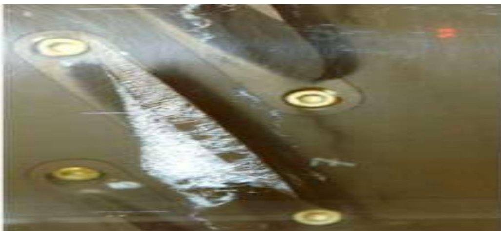
Figure 11 (II.9) : Cavitation à poches sur un entre fer de roué
