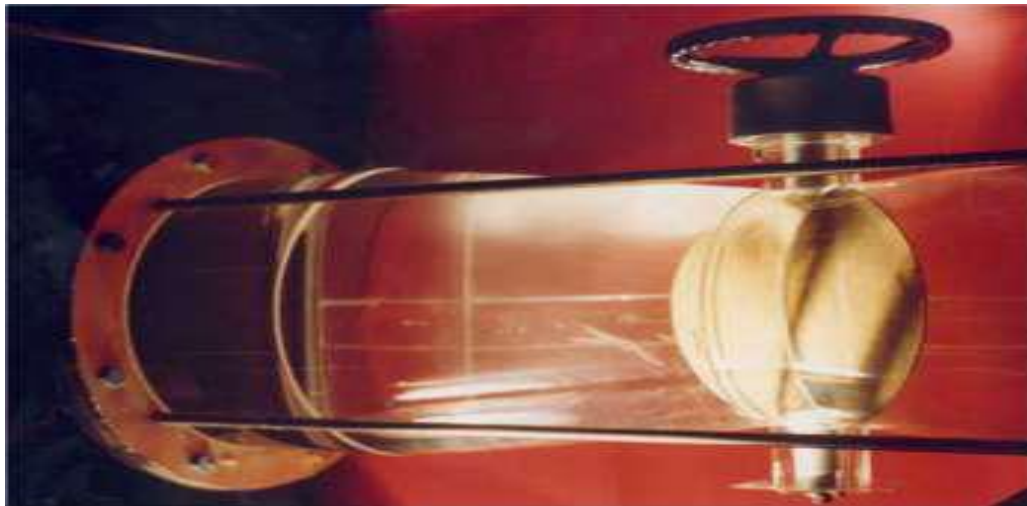
Figure 14 (II.12) : cavitation de mélange en aval d'une vanne papillon
