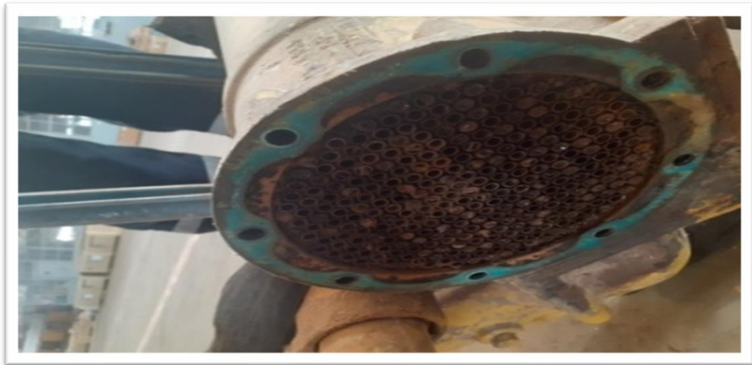
Figure 15 (III.1) : bouchage de reforgeuront d'huile.
