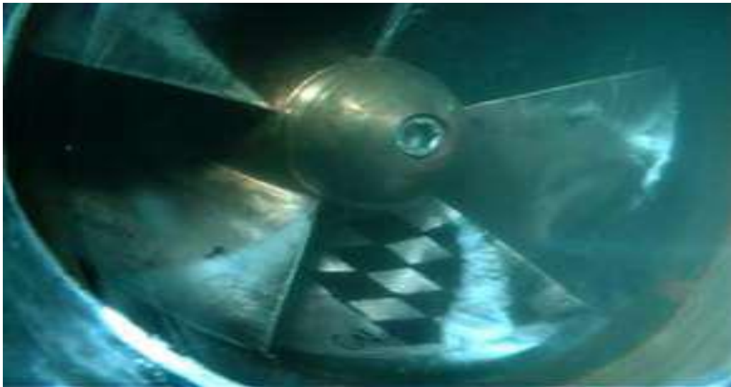
Figure 10 (II.8) : Cavitation à poches sur une roue de pompe
