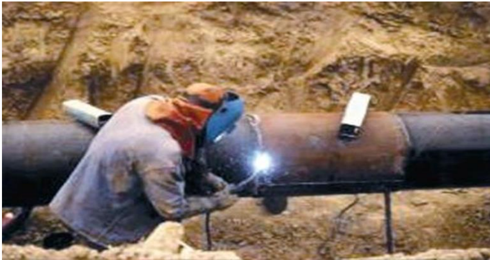
Figure II.17 Opération de soudages de demi-coquilles (STT) [17].
