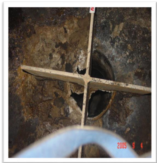
Figure I.2 : l'encrassement au fond de la colonne de distillation
