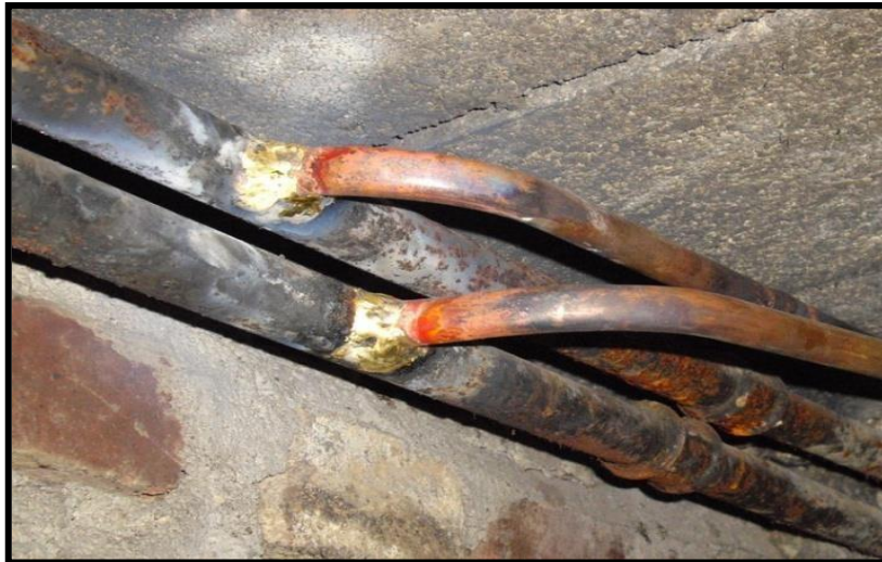
Cuivre et acier noir dans une installation
