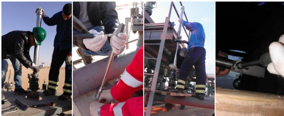
**Figure II.11** : Déroulement de l'opération de l'installation des coupons de corrosion au niveau de la ligne 6'' du circuit huile (tête puits RB 57 et arrivée sur manifold sud huile RB 57)
