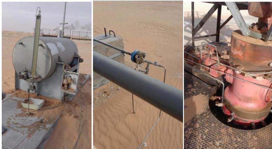
**Figure II.10 :** point d'injection, pompe d'injection et remplissage du produit CRW 83133 dans le bac au niveau du circuit huile
