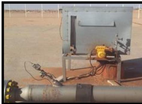
**Figure II.6 :** *Pompe doseuse responsable à injecter l'inhibiteur de corrosion*
