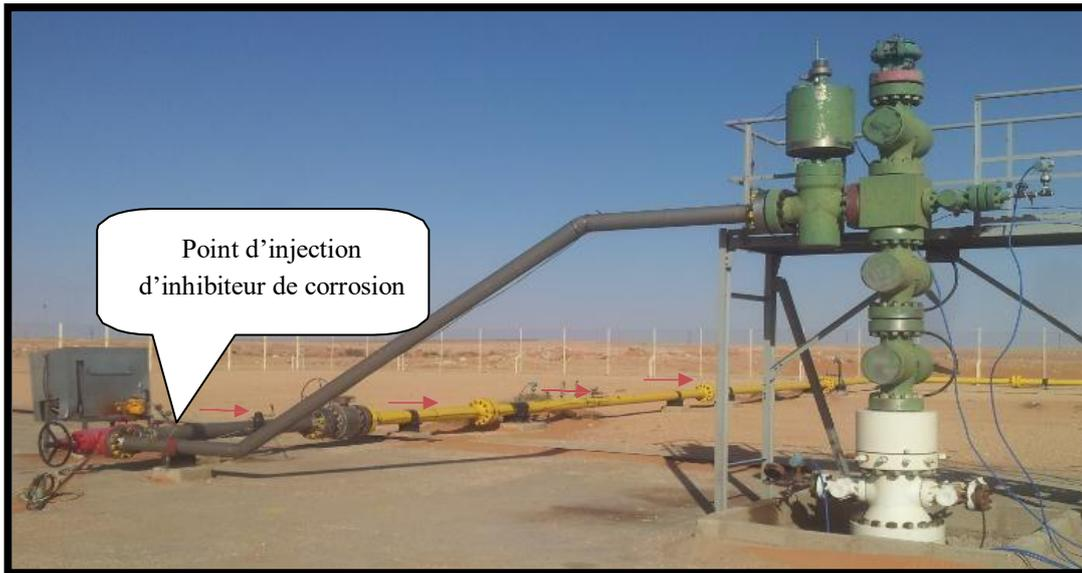
**Figure II.5 :** *Point d'injection de l'inhibiteur de corrosion au niveau du puits*
