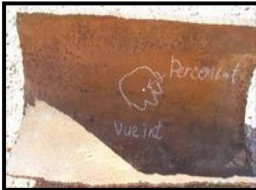
Figure II.3.1 : Percement d'une conduite enterrée (vue interne)
