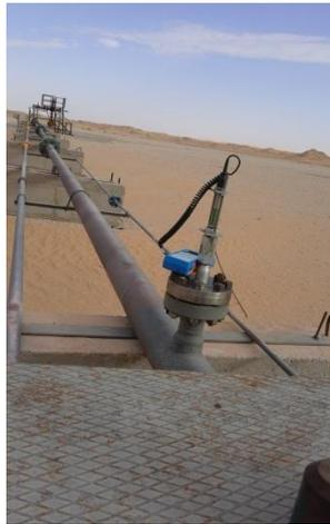
**Figure II.9 :** Sonde ER installée le 14/02/2016 à 10h00 au niveau de la ligne 6'' du puits producteur d'huile RB57
