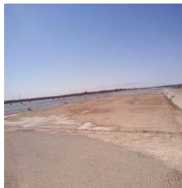
Figure 11: Présentation d'un lit de séchage.
