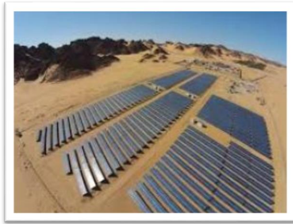
Figure III.4 : Centrale solaire photovoltaïque d'Aïn El Melh de M'sila [86].
