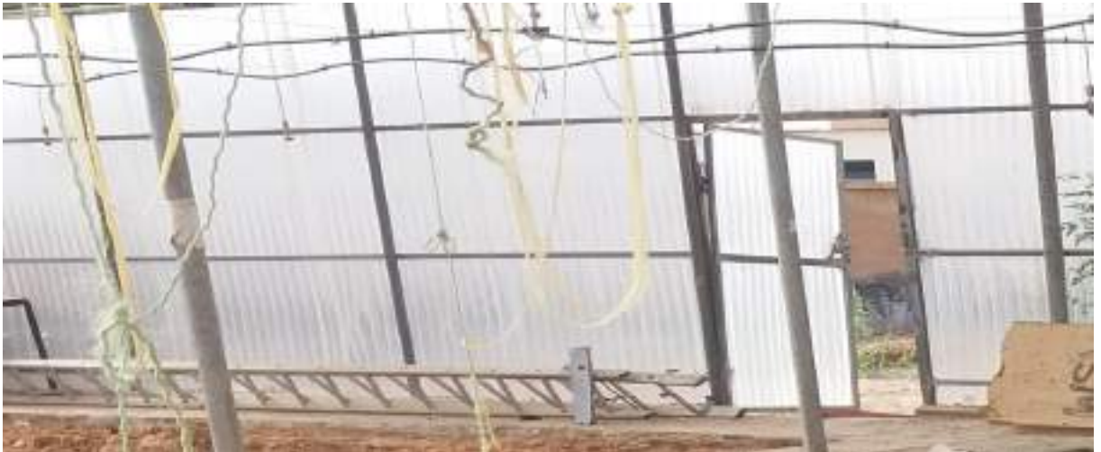
Photo 16. Aération de la serre
