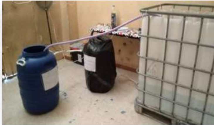
Figure n°05 : Installation du système fermé
