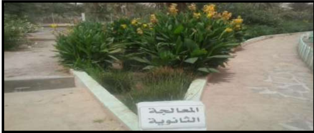
Figure 20 bassins WWG (traitement secondaire)
