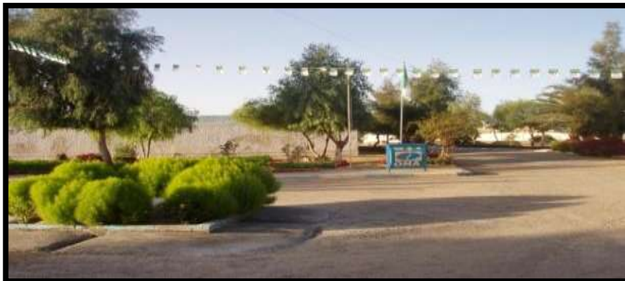
Figure 25 photo de la station d'épuration de Touggourt(ONA).
