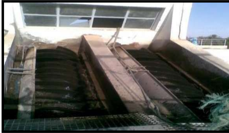
Figure 31 Boues de recirculation
