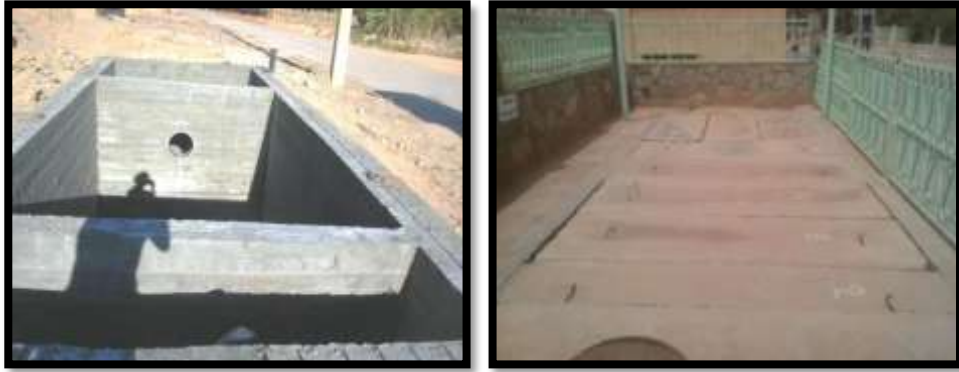
Figure 18 Vue générale de la fosse septique (Bouzaher S ; 2018).
