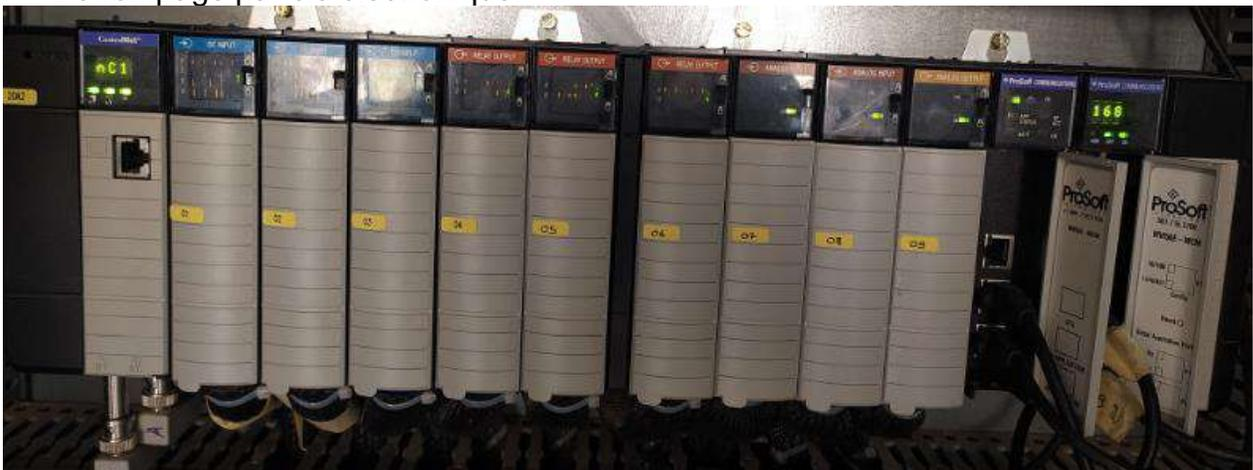
Figure 2. 7. Modules E/S dans châssis 1756-A13
