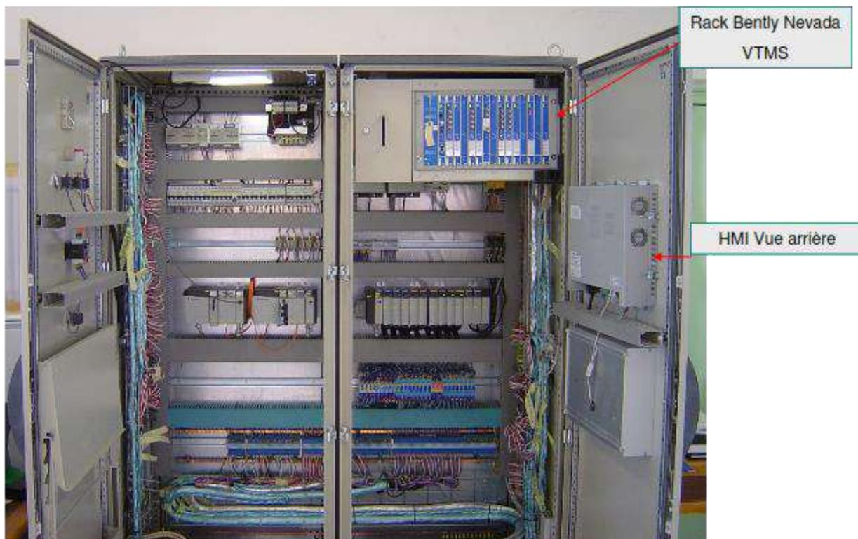
Figure 3. 10. UCP vue de l'intérieur rack VTMS
