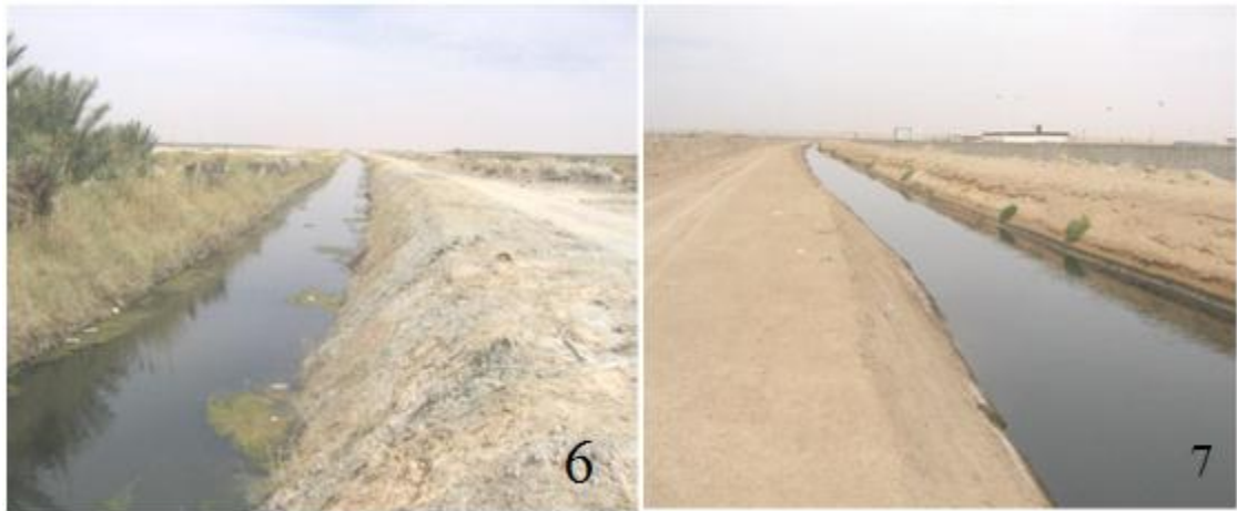
Photo 6: Drain principal côté Est
