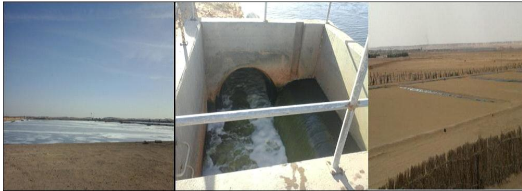
Photo 3: lagune d'aération, sortie de l'eau traitée et lits de séchage des boues.
