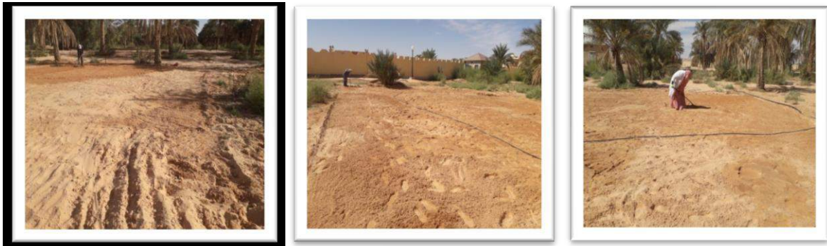
Figure 12: Le nivellement de site de l'essai.
