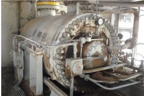
Figure II.12.1 : Compresseur à barrel. Elliott 38 MB 8
