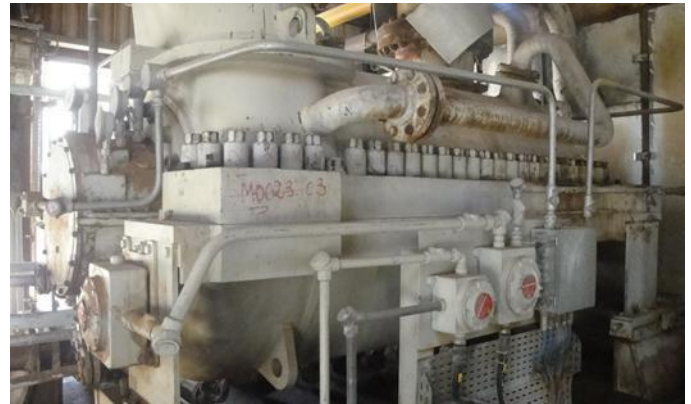
Figure II.12.2 : Compresseur à plan de joint Horizontal. Elliott 46 M 7
