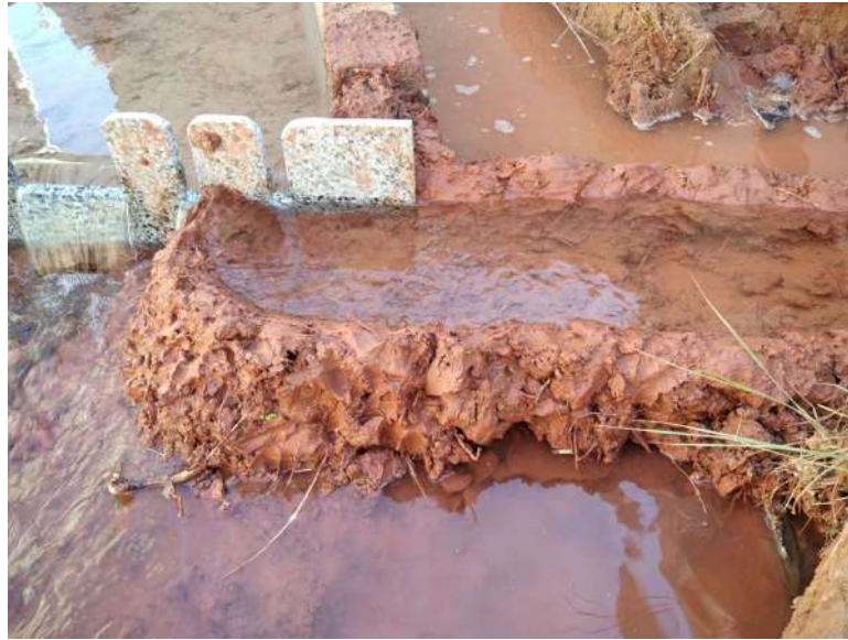
Figure 26 Vérification de pente entre l'amont et l'aval du déversoir de partage.
