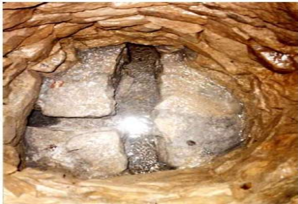
Figure 16 Vue aérienne d'un puits appartenant à l'aqueduc souterrain des Raschpëtzer [28].
