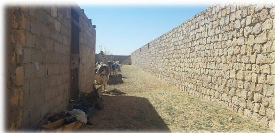
photo 11: Bâtiment de l'exploitation Neciri.
