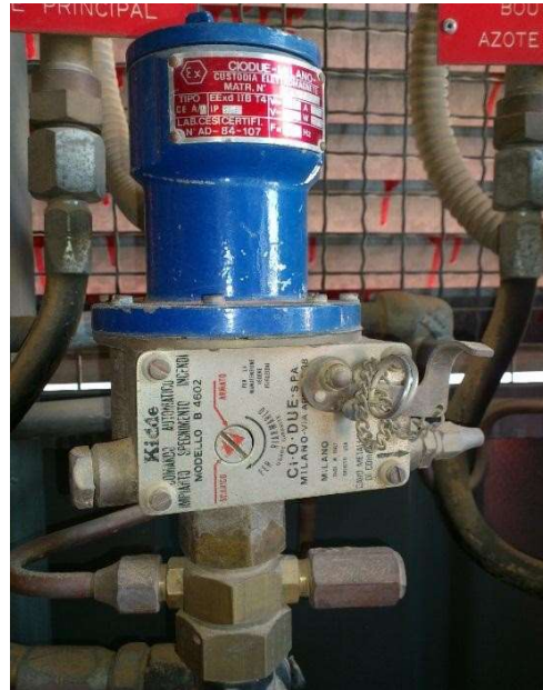
Figure 1.19 : Une électrovanne montée sur une bouteille CO2
