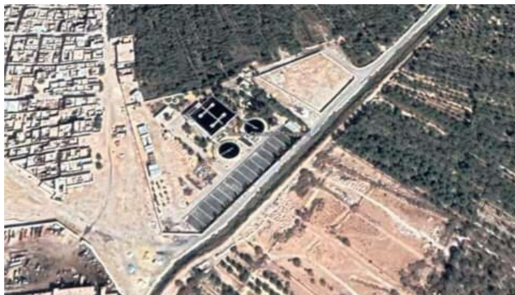
Figure 6 : Vue satellitaire de la station d'épuration de Touggourt
