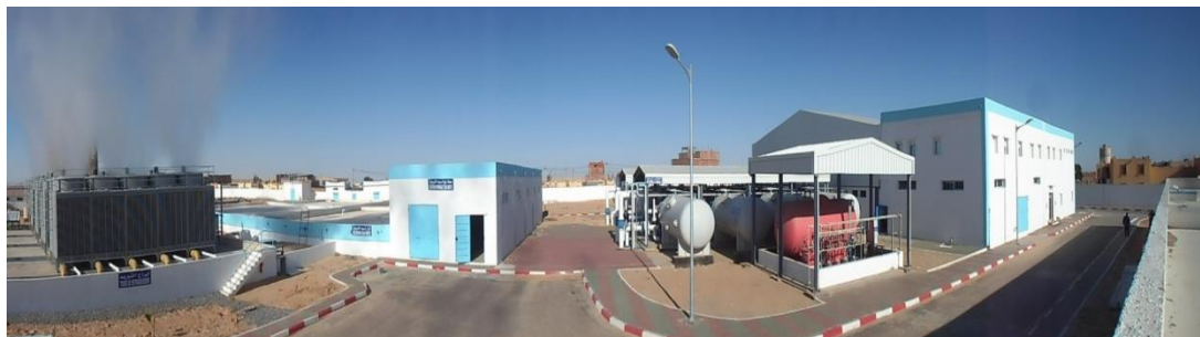
Figure 5.2 : Vue de la station de déminéralisation.
