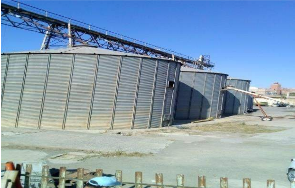
Figure 3 : Silos métalliques (Lakhial., 2018)
