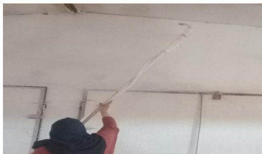
Photo 09 : Chaulage des murs
