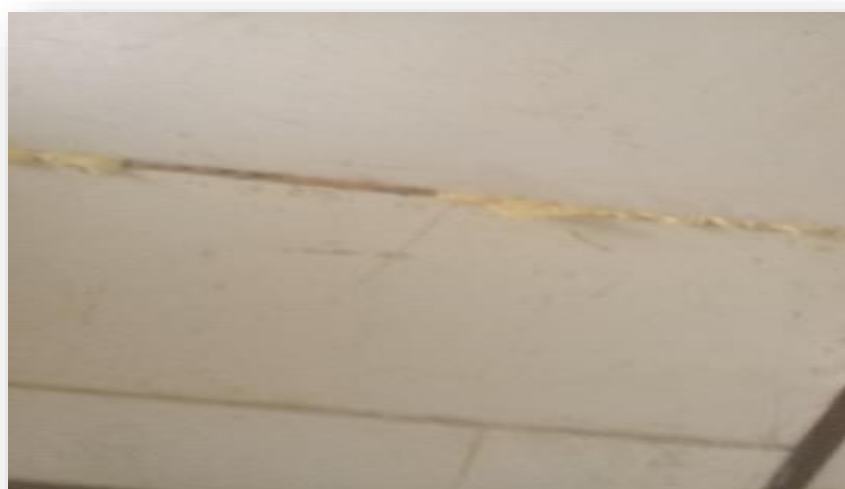
Photo N° 04 : Toits en panneaux sandwich
