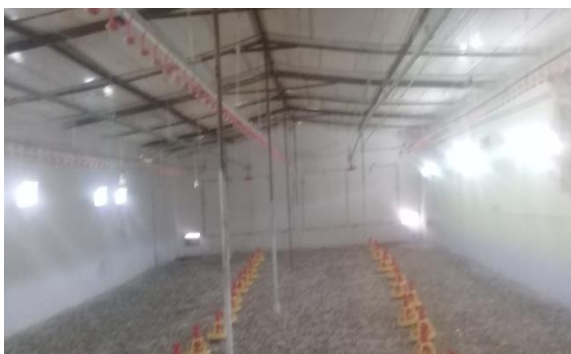
Photo 05 : Aération du bâtiment
