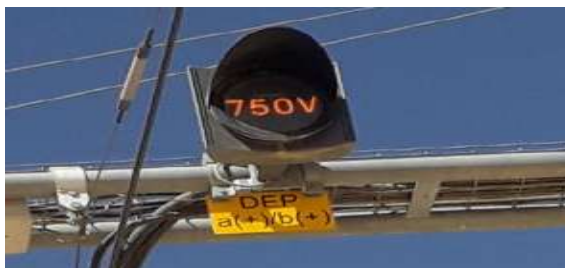
FIGURE II.19 – Feux de présence tension.[22]
