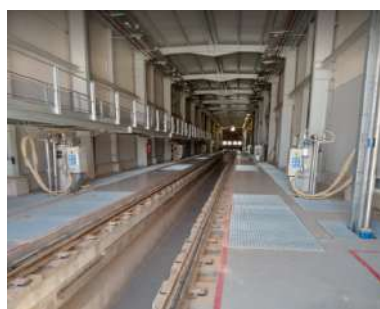
(b) Le bâtiment de lavage
