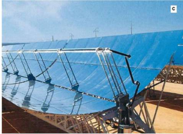
Fig3.4 : Les captures cylindro-paraboliques. [3]
