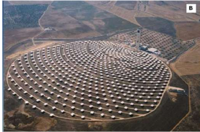
Fig 3.3 : Centrale solaire à tour[3]
