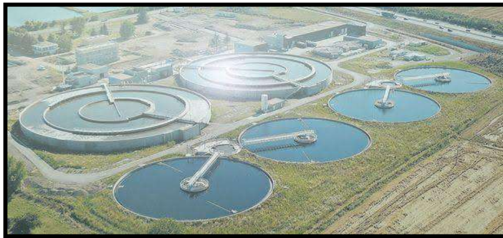
الشكل (III - 1): محطة معالجة المياه المستعملة
