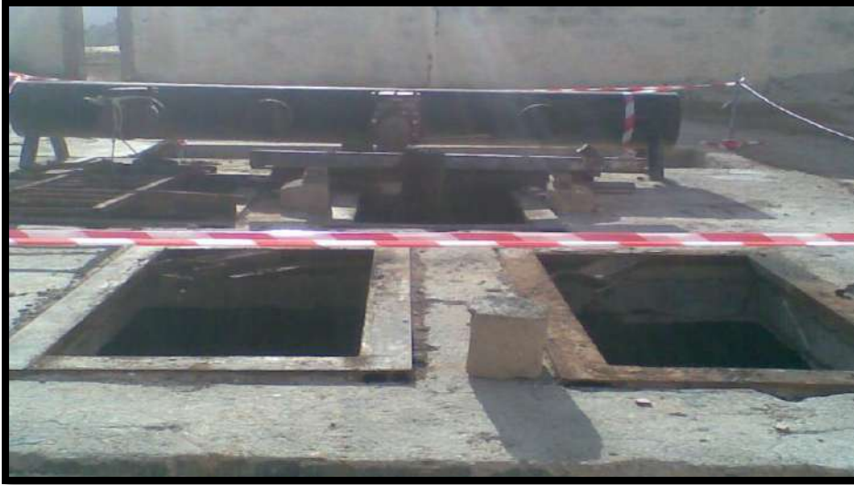
الشكل (IV- 4): عملية الرفع
