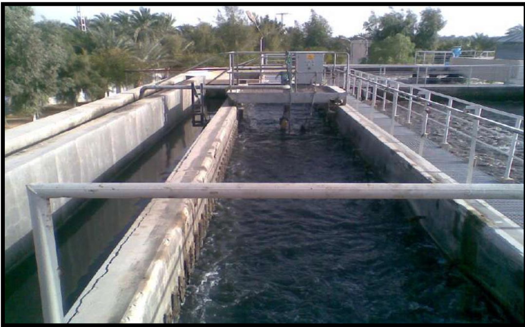
الشكل (IV- 6) :عملية إزالة الزيوت والحصى
