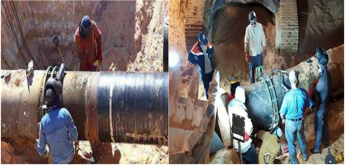
الشكل ( IV -6): صورة توضح عملية صيانة وتلحيم للتسرب الحاصل على مستوى خط انبوب نقل
