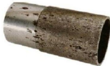
الشكل (1 - 5) : صورة للتآكل النقري [5]
