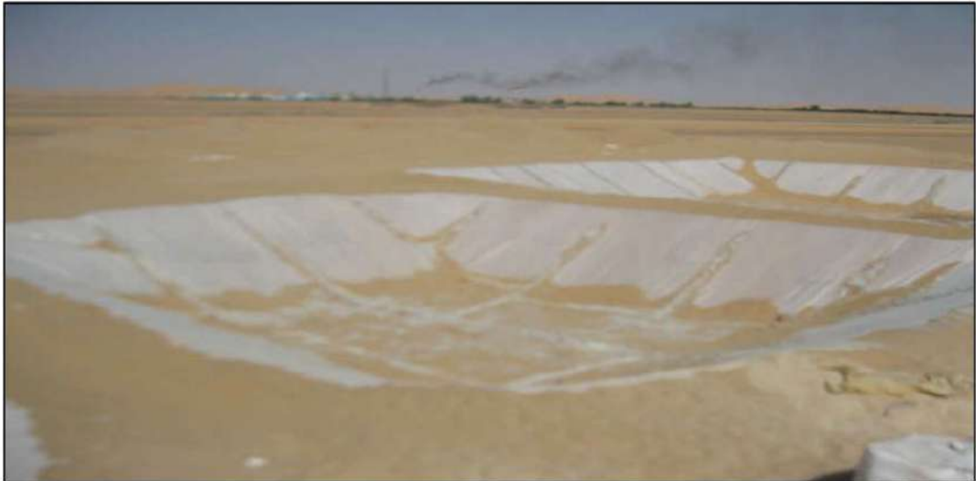
Figure.III.8.Bourbiers étanche avant le forage[32].
