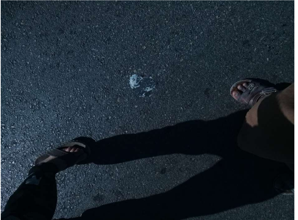
Figure. 9 photographie bon béton bitumineux de la chaussée
