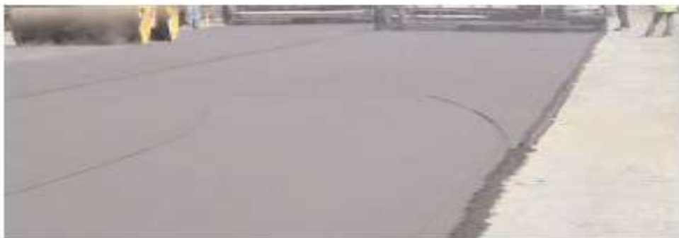
Figure II.8 arrêt de compaction en obliquant
