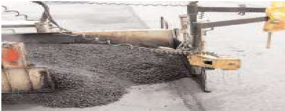
(figure II.16. Chevauchement des bandes)
