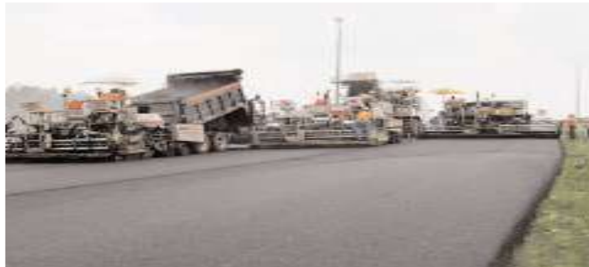
(figure II.15) Finisseurs en échelon
