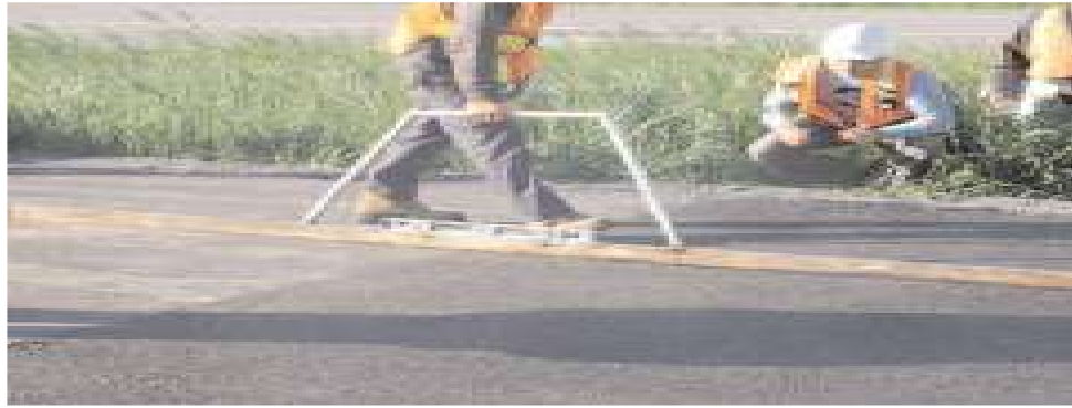
(Figure II.13) Vérification de l'uni avec la règle de 3 mètres
