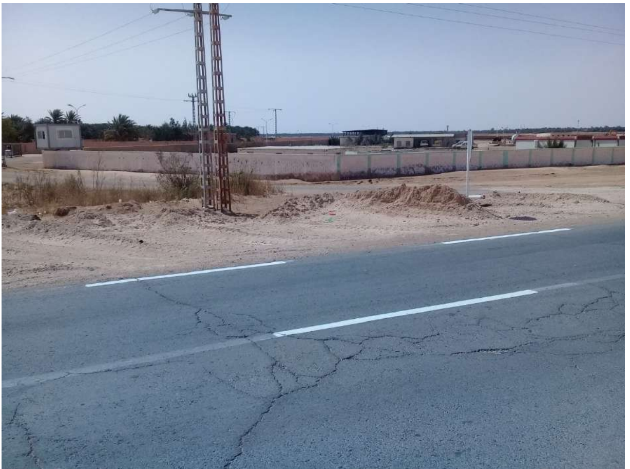
Figure 6 photographie de faïençage à mailles larges
