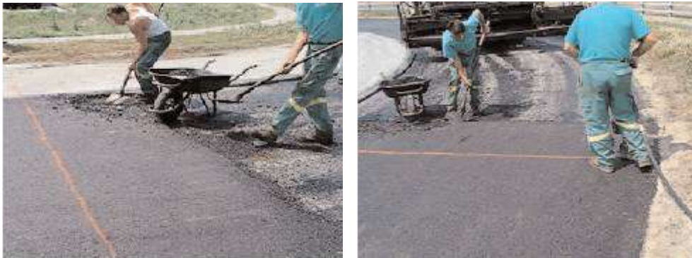
Figure II.12 Reprise des travaux
