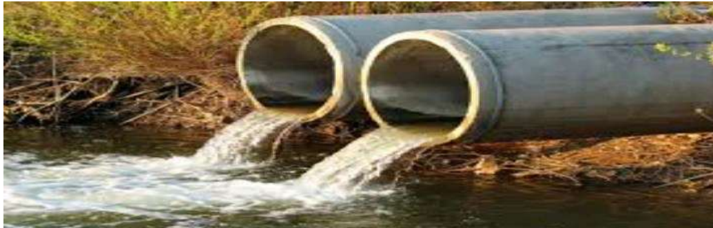
الصورة (1-1): مياه صرف صحي
