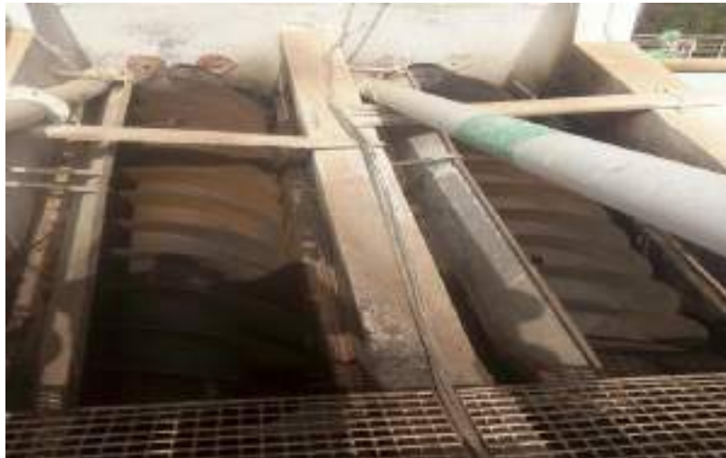
Photo.7: vis d'Archimède
