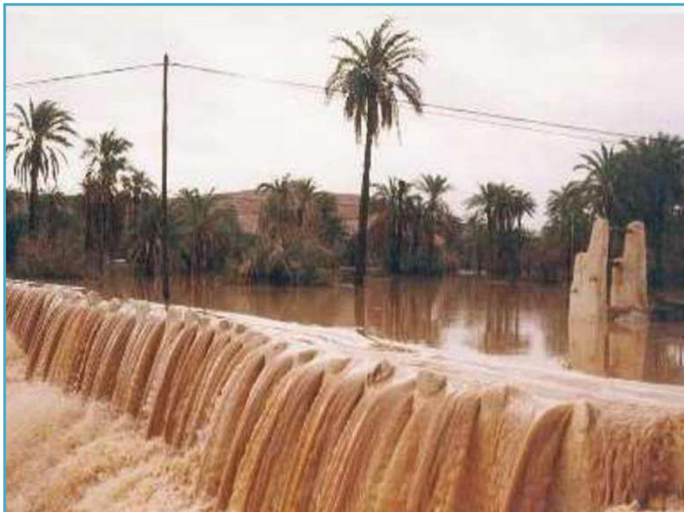
Photo 2. Barrage de retenue Béni-Isguen (BENSAHA et al. , 2011)
