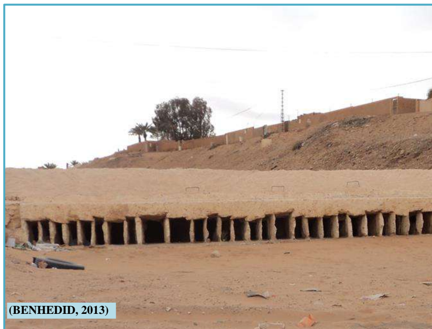
Photo 1. Barrage de dérivation de Bouchen en amont de la palmeraie de Ghardaïa
