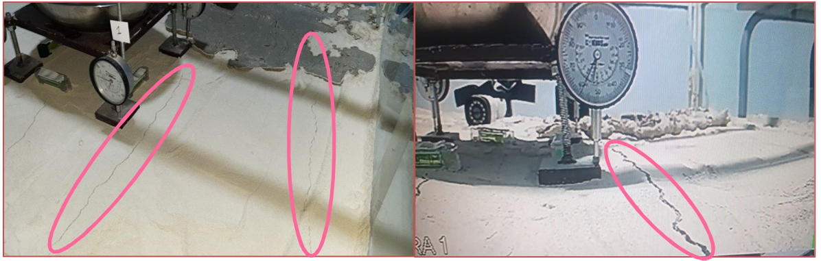
Figure (V.10). Apparition de fissures à la surface de la couche argileuse.
