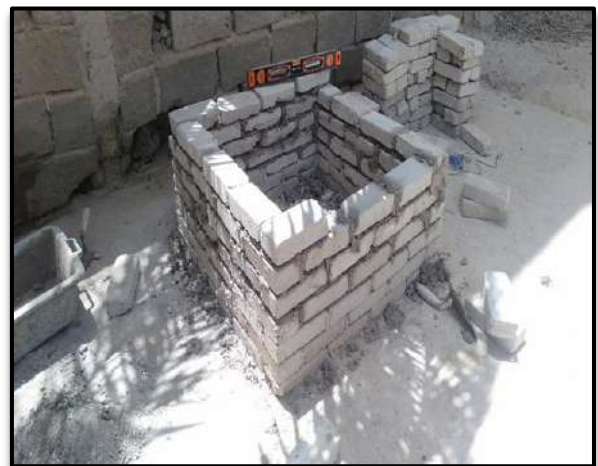
Figure III.18 Parois en Timchemt.
