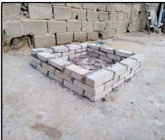
Figure III.17 Mise en place des briques
