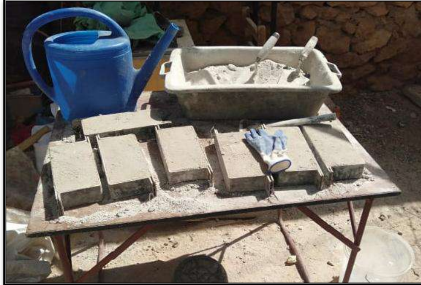
Figure III.3 Moulage des briques.
