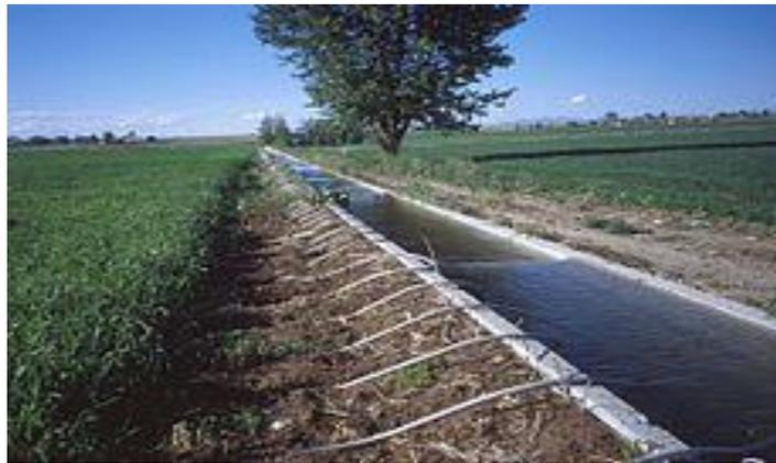
**Figure I. 10 Alimentation des planches par siphon**
