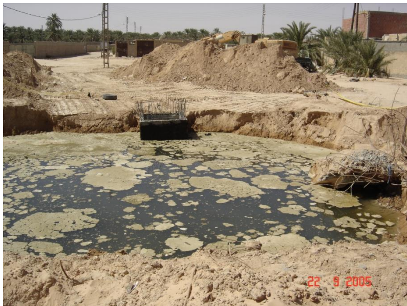
Figure (II.05) : Débordement des eaux usées lors d'un arrêt de pompag
