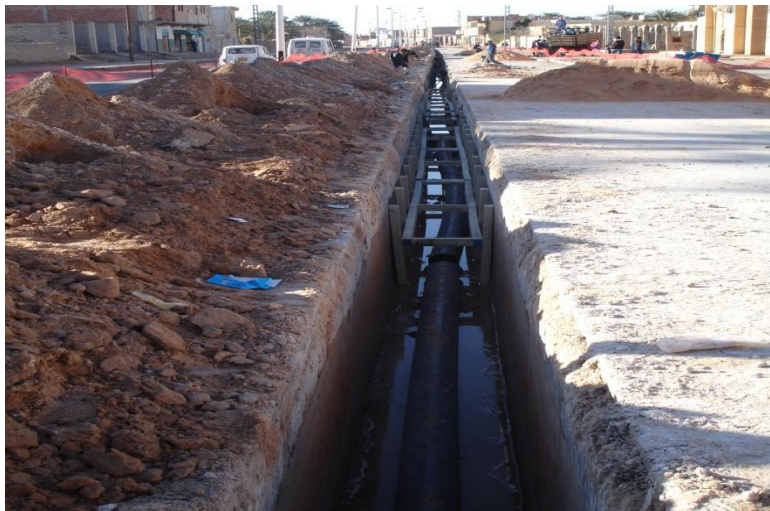
Figure (II.03) : Niveau de la nappe phréatique au quartier "Sokra".
