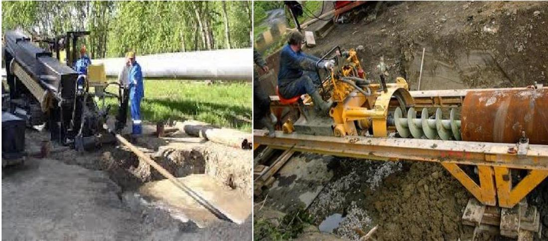
**Figure 7- Images apparaitre le forage horizontal.**
